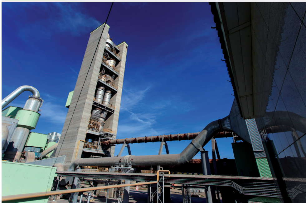
1. TORRE A CICLONI DELLA LINEA 5 DI SUKHOI LOG / LINE 5 PREHEATER TOWER AT SUKHOI LOG
